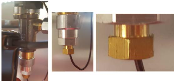
SI AL PULSAR EL BOTÓN DEL PIEZO ELÉCTRICO SUCEDE LA CHISPA PERO NO LA LLAMA, TAMBIÉN PUEDE SER QUE SE HAYA AFLOJADO LA TUERCA DORADA QUE CONECTA EL CABLE DE CONEXIÓN CON EL TERMOPAR.
