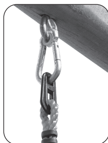
DETALLE DE FIJACIÓN EN EL LUGAR
