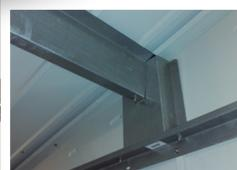
Viga con un raíl galvanizado y travesaños de metal que proporciona soporte al tejado y una mayor resistencia de construcción.
